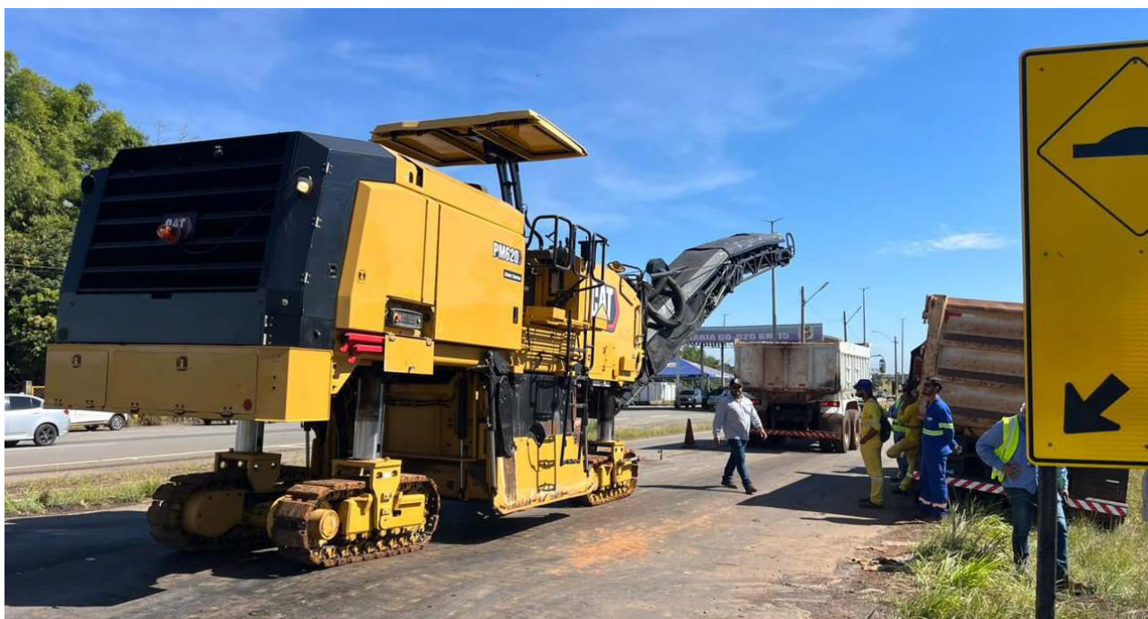
Governo inicia restauração da pavimentação da GO-020, em Goiânia, com primeira etapa de trabalhos entre o Posto Policial e a indústria Ciel
