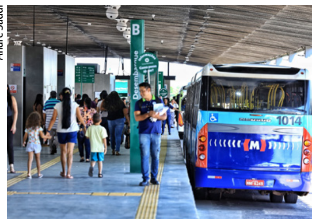
Estrutura oferece mais praticidade e conforto aos usuários, por meio uso de tecnologias e monitoramento de segurança
