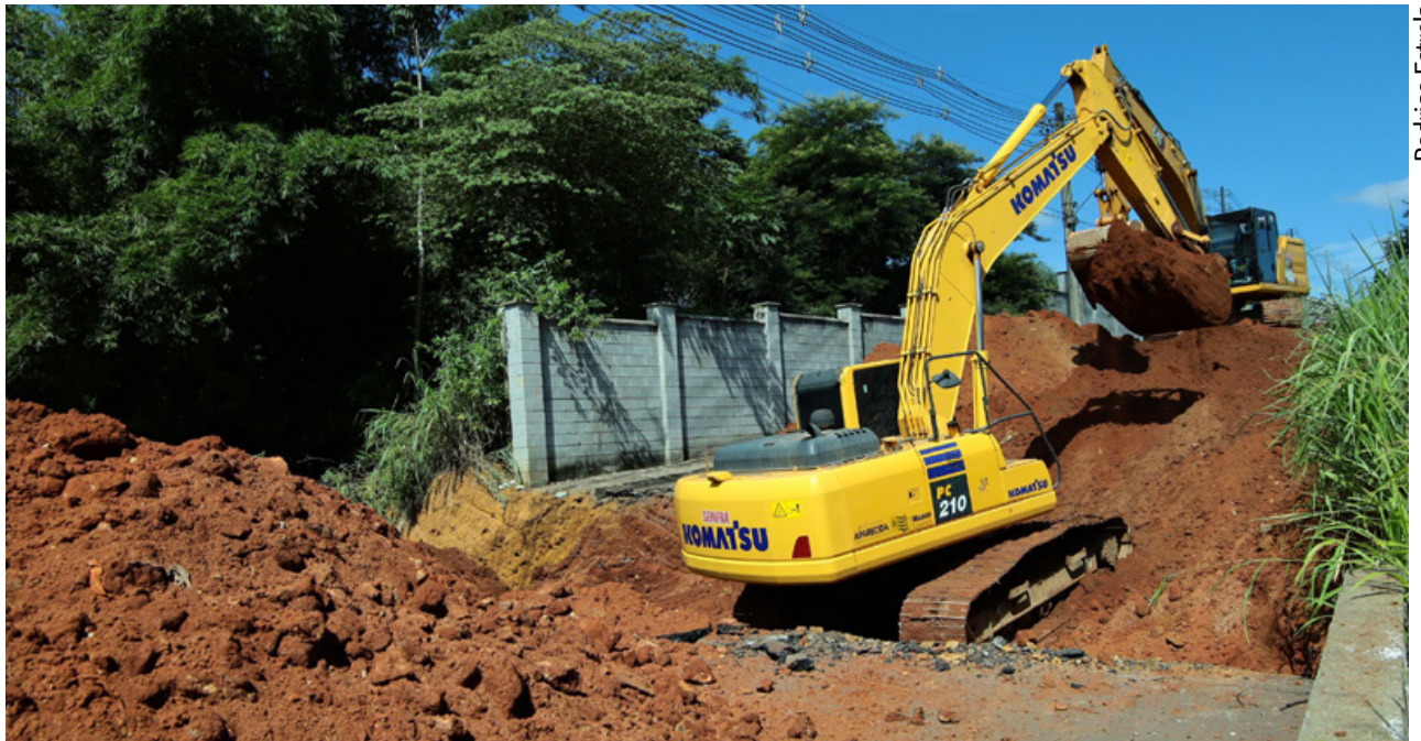
Máquinas trabalham na obra para recuperar a ponte do Parque Real, próximo à BR-153
