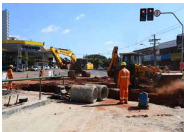
Operários trabalham na obra de adutora na Avenida Anhanguera
