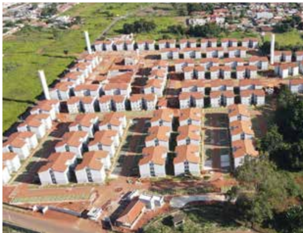
Imagem aérea dos módulos habitacionais na região da Chácara São Pedro, em Aparecida: unidades serão entregues durante Mutirão
