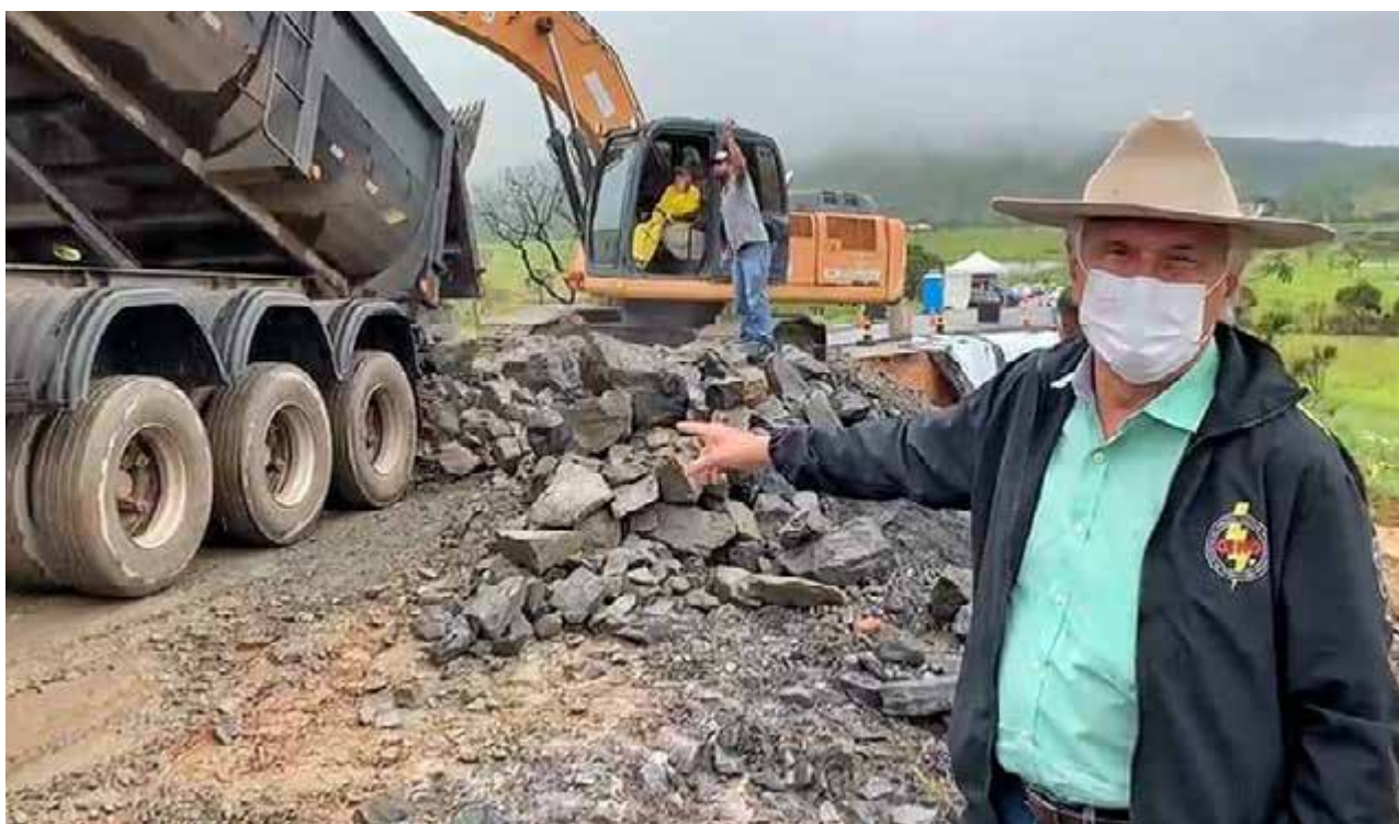
Governador Ronaldo Caiado na vistoria com técnicos da Goinfra, na GO-118, em Alto Paraíso de Goiás: “Não é um trabalho fácil, porque estamos trazendo o material de Planaltina de Goiás para fazer o escoramento de toda área que desabou”
