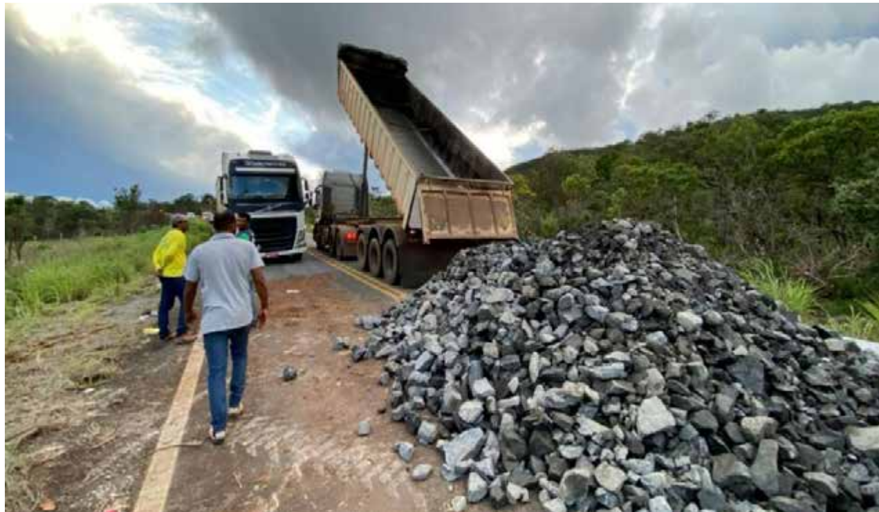
Recuperação da erosão na GO-118, entre Alto Paraíso e Teresina de Goiás, será executada em 45 dias trabalhados
