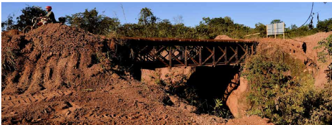
Ponte de madeira, sobre o rio Taperão, em Formosa, que será substituída por uma estrutura muito mais resistente, de metal
