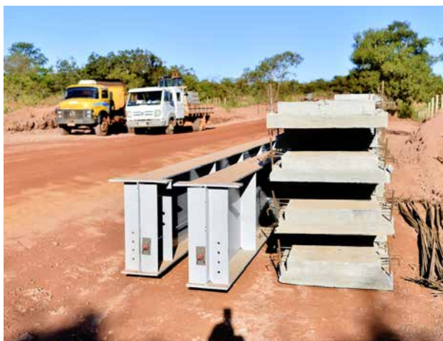
Material para a construção da ponte sobre o rio Taperão, em Formosa
