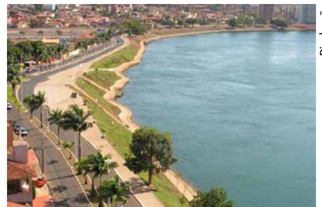
Também no município, Caiado visita central de tratamento de resíduos sólidos e geradores de energia elétrica.
