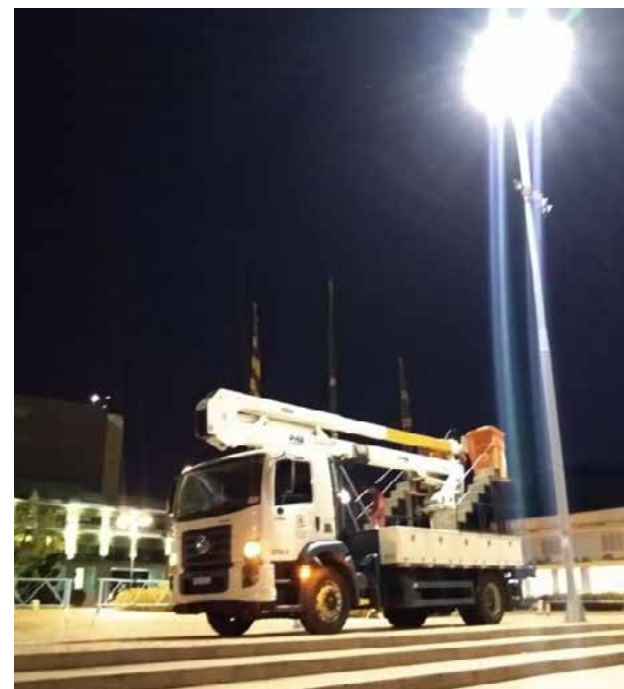
Nessa semana, as frentes de serviço estão espalhadas por diversos setores
