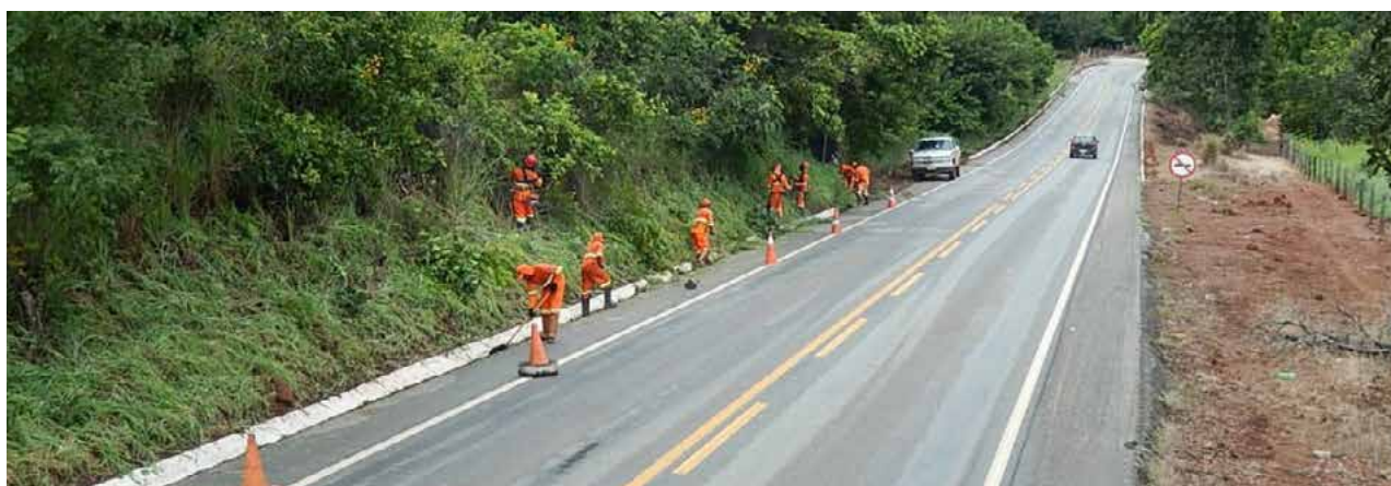
Restauração da rodovia GO-326, entre Sanclerlândia e Buriti de Goiás. Trecho de 15,5 km
