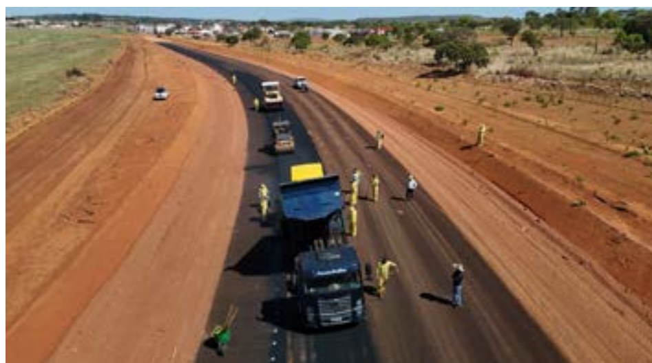
Goinfra inicia a aplicação de capa asfáltica nas frentes de serviços de pavimentação da GO-219, entre Hidrolândia e Bela Vista de Goiás: tráfego deve ser liberado em um terço do trecho até o final do ano
