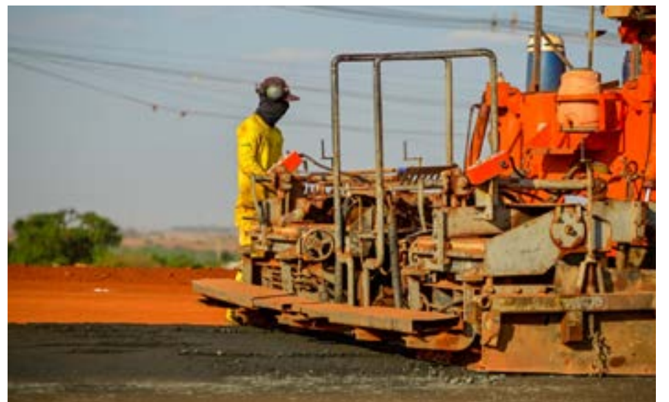
Obras do Fundeinfra seguirão em ritmo acelerado. Pavimentação e recuperação de rodovias estaduais beneficiam diretamente 9,6 mil empreendimentos rurais em 19 municípios goianos
