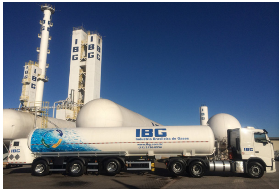
IBG deve gerar 60 empregos diretos e indiretos durante as obras de sua nova unidade, em Anápolis
