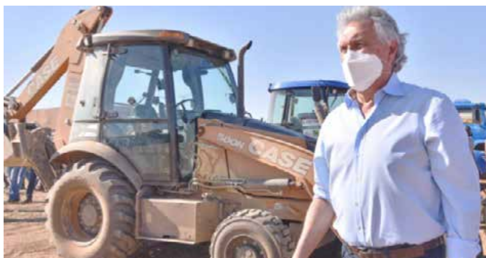
Caiado inspeciona semanalmente as obras de reconstrução das rodovias e confere o andamento e qualidade do trabalho
