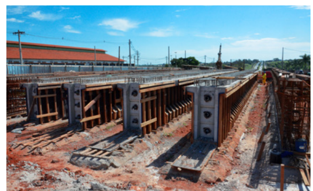
Obras do Viaduto Portal da Fé, em Trindade: cronograma de trabalho segue inalterado mesmo com as chuvas
