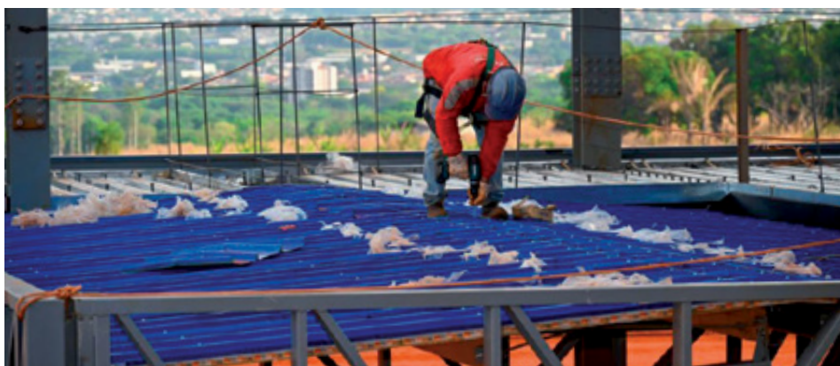
Fundações, lajes e armações da ala infantil do Complexo Oncológico de Referência de Goiás (CORA) foram finalizadas, representando 40% do total da obra.
