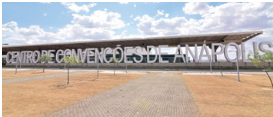
Centro de Convenções de Anápolis também foi abandonado em 2018, após receber R$ 154 milhões para obras
