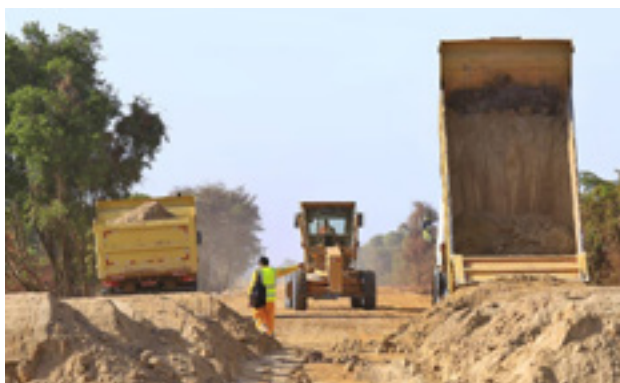
Obra de pavimentação da GO-454, no trecho que liga a GO-164 à divisa entre Goiás e Mato Grosso, na cidade de Cocalinho, recebeu investimentos de mais de R$ 64 milhões
