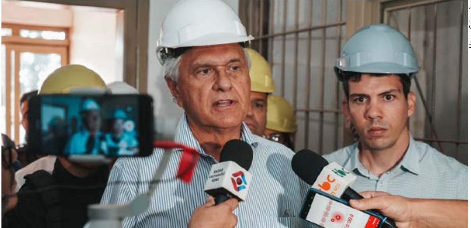
No Entorno do Distrito Federal (DF), Caiado vistoria obras de novo presídio em construção no município de Novo Gama
