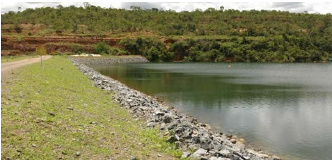
Processo de cadastramento de barragens começou na Semad em 2019 e alcança números expressivos após quatro anos
